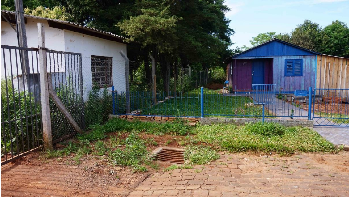
Figura II-13 – Casa em área de risco nas proximidades da ETE
