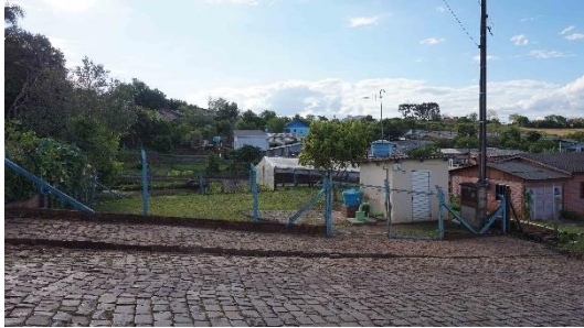
Figura IV-35 - Captação de água bruta Poço SJA-11
