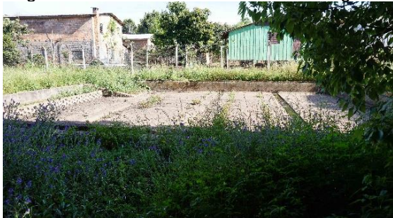
Figura IV-99 – Vista 01 do leito de secagem
