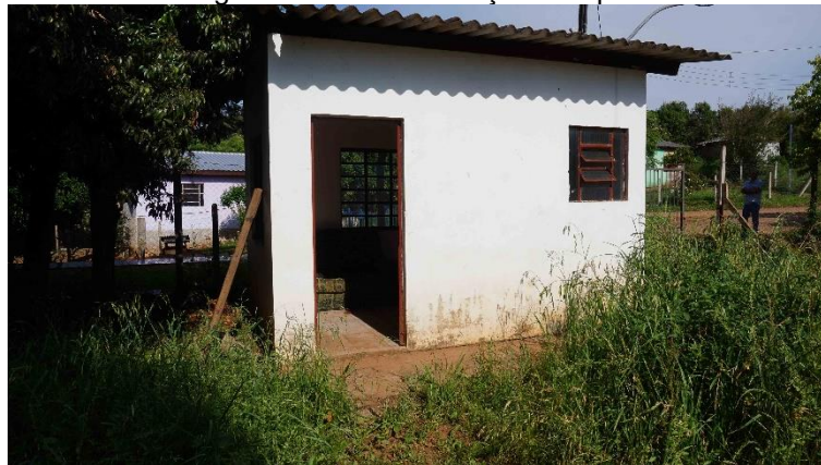
Figura IV-109 – Edificação de apoio
