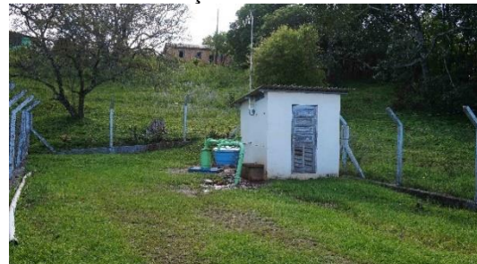
Figura IV-34 - Captação de água bruta Poço SJA - 10
