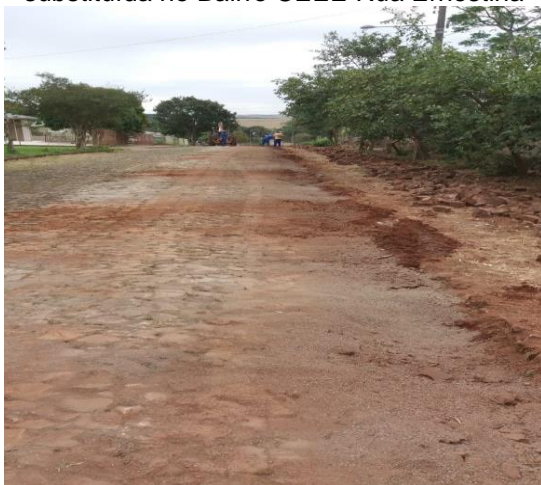
Figura IV-69 - Rede de distribuição de água substituída no Bairro CEEE Rua Ernestina
