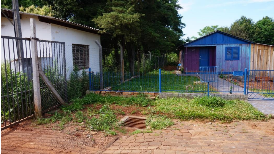
Figura IV-114 - Casa em área da risco
