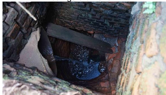
Figura IV-161 – Detalhe interno do bueiro da figura anterior
