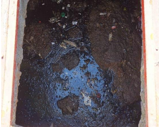
Figura IV-95 – Situação do lodo interno do reator
