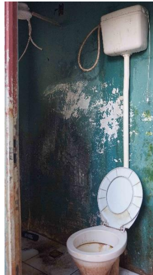
Figura IV-118 – Vista interna do banheiro
