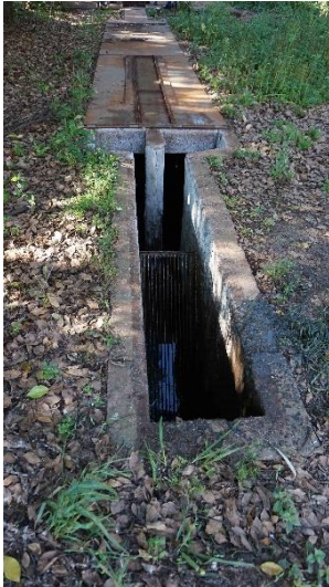
Figura IV-87 – Vista da entrada do desarenador
