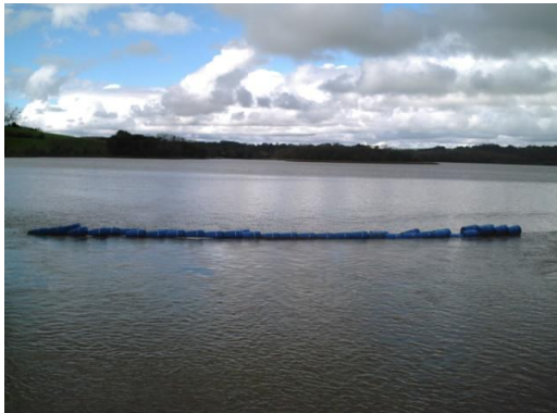
Figura IV-27 - Manancial de captação de água bruta - Rio Jacuí
