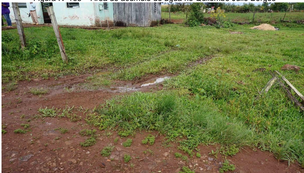
Figura IV-163 – Área de acúmulo de água no Quilombo Júlio Borges
