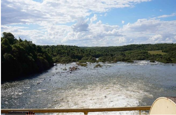
Figura IV-25 - Manancial de captação de água bruta
