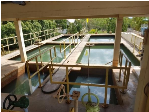
Figura IV-43 - Detalhe da infraestrutura da ETA
