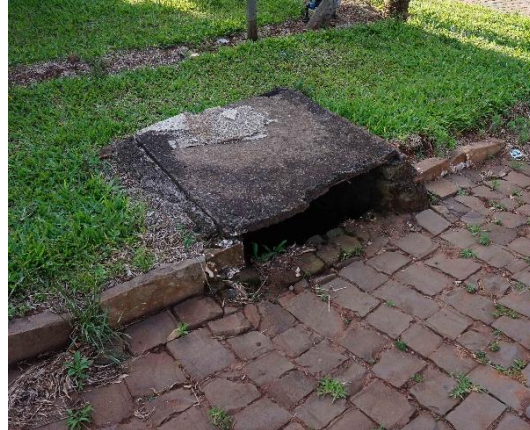
Figura IV-157 – Sistema de microdrenagem na área urbana
