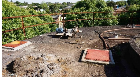
Figura IV-98 – Acúmulo de resíduos retirados do reator e 2º conjunto moto bomba ao fundo
