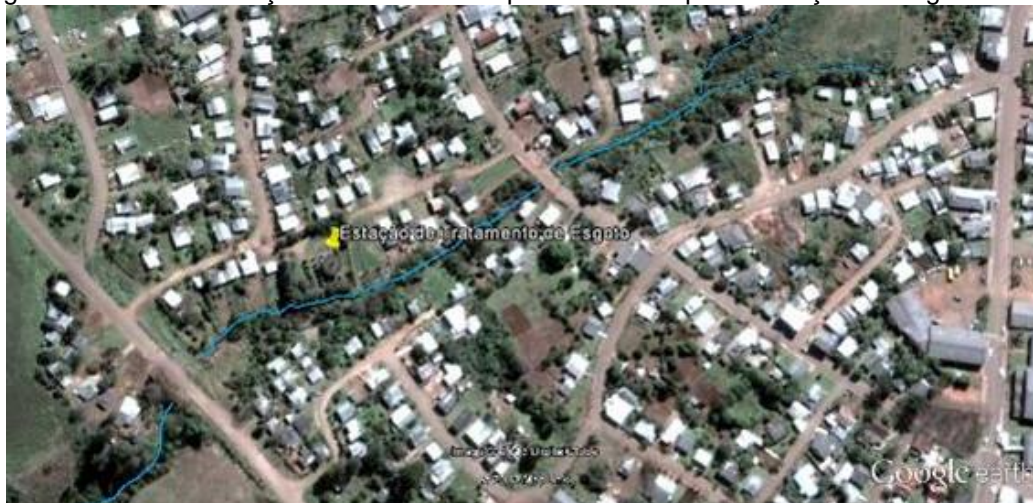
Figura IV-111 - Localização da ETE e do corpo hídrico em que era lançado o esgoto tratado
