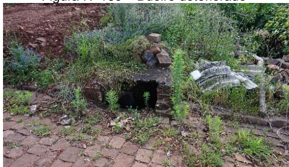
Figura IV-160 – Bueiro deteriorado
