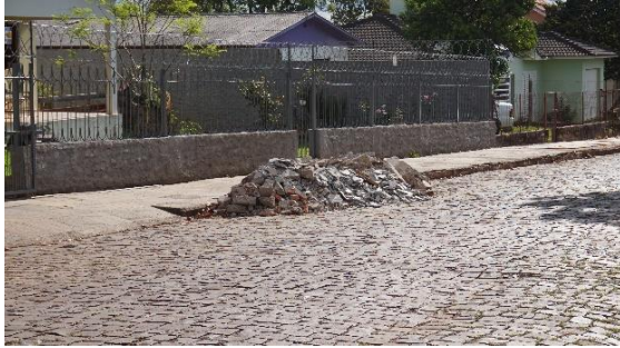
Figura IV-132 – Resíduos de demolição na zona urbana
