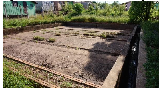
Figura IV-100 – Vista 02 do leito de secagem
