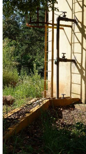
Figura IV-108 – Registros em 3 alturas para retirada do lodo do reator
