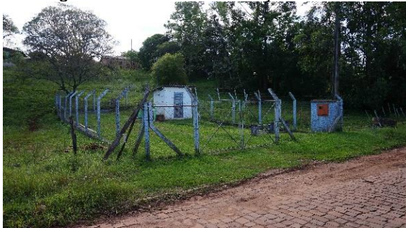
Figura IV-33 – Vista do Poço SJA - 10
