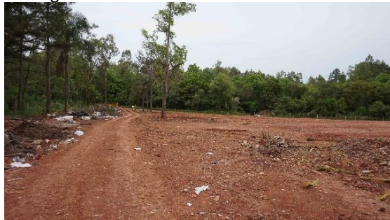
Figura IV-152 – Vista do acesso à área
