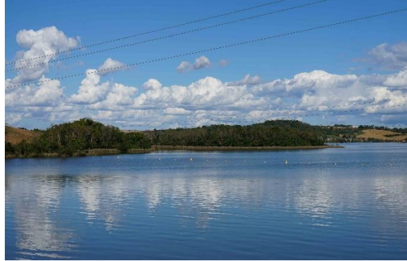
Figura IV-26 - Manancial de captação de água bruta – alagado da barragem Maia Filho
