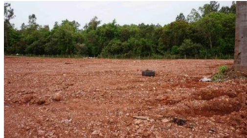
Figura IV-153 – Parte frontal da área já aterrada
