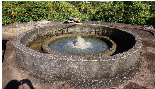
Figura IV-93 – Situação do vertedor superior do reator
