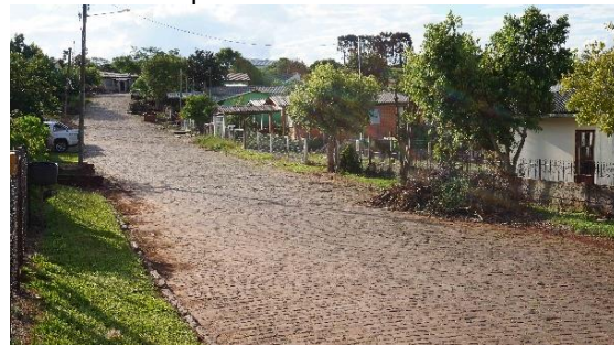
Figura IV-131 - Ponto 08 com resíduos de poda acumulados
