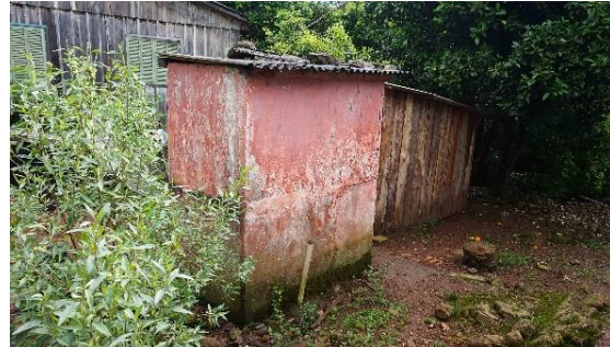
Figura IV-121 – Antigo banheiro em vermelho, fora de funcionamento
