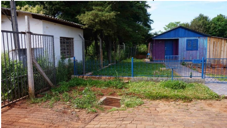
Figura IV-165 – Casa em área de risco nas proximidades da ETE
