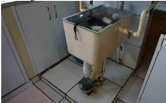
Figura IV-49 – Tanque de mistura
