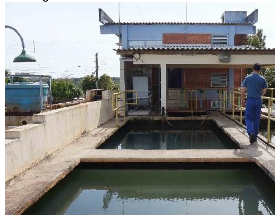
Figura IV-44 – Vista interna da ETA
